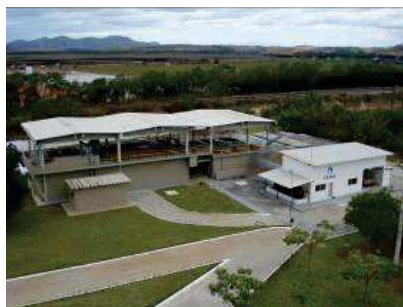
ETA SANTA MARIA VISTA GERAL
