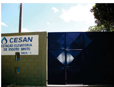
EEEB SOTECO MURO E PORTÃO
