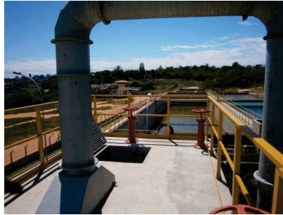
ETE OLARIA - GUARAPARI TRATAMENTO DE GASES
