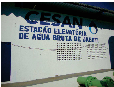
CAPTAÇÃO JABOTI - GUARAPARI EEAB - VISTA GERAL
