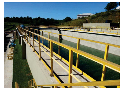
ETE OLARIA - GUARAPARI VISTA GERAL – GUARDA CORPO
