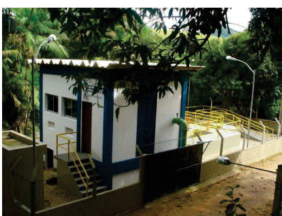
CAPTAÇÃO VIANA VISTA GERAL
