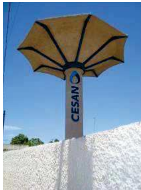
RESERVATÓRIO ELEVADO MUQUIÇABA GUARAPARI
