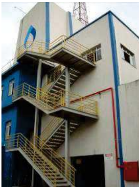
ETA COBI ESCADA METÁLICA
