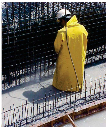
Escarificação, limpeza, colocação do espaçador e selante expansivo
