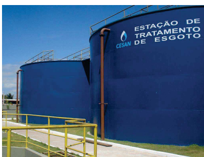
ETE ULISSES GUIMARÃES VISTA GERAL
