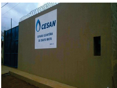
EEEB BOM JESUS DO NORTE MURO E PORTÃO
