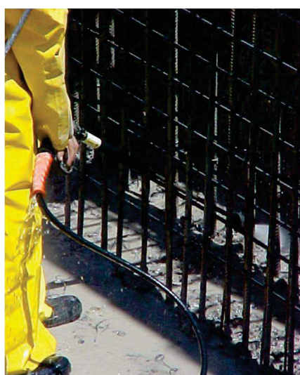
Escarificação, limpeza, colocação do espaçador e selante expansivo
