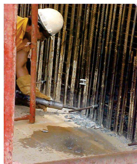
Escarificação, limpeza, colocação do espaçador e selante expansivo
